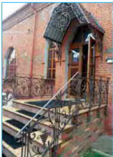
Оформлення кованими решітками входу в будинок
